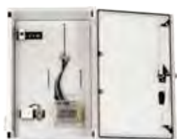
Armário de Telecontagem
